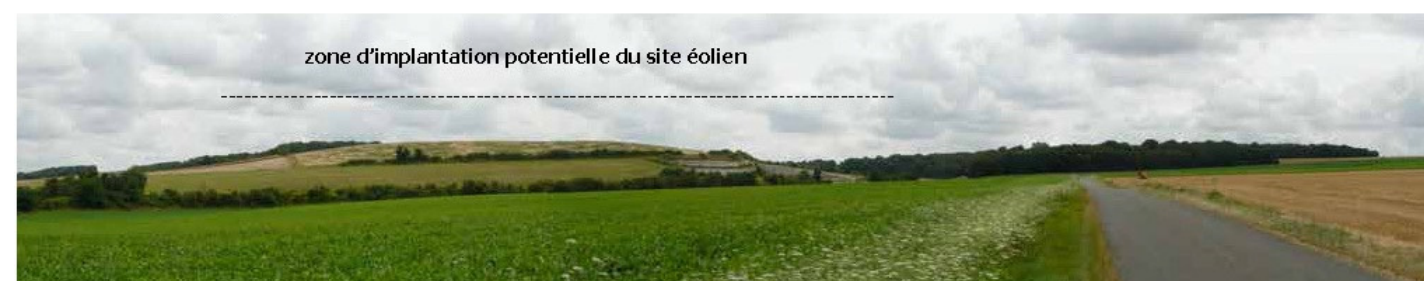
Figure 57 : Vue vers l'est et le site depuis la sortie ouest de la Neuville-Sire-Bernard
